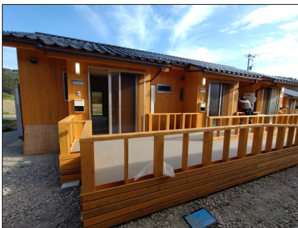
仮設木造住宅
